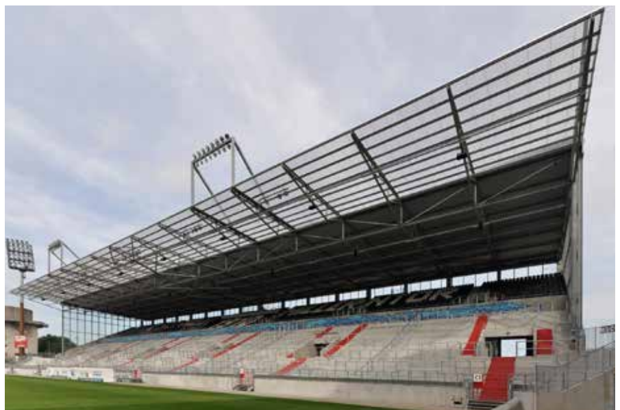
Bild 6: Dachuntersicht mit filigranen Fachwerkträgern
