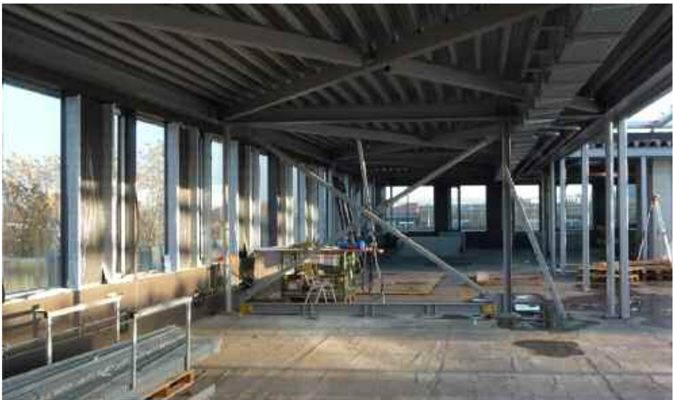
▲ Stahlkonstruktion der Aufstockung im Bau
