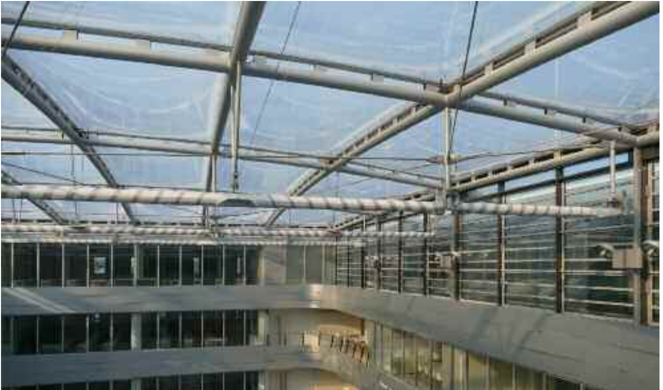
▲ Unterspannte Dachkonstruktion mit eingerollten, dreieckigen Sonnenschutz-Segeln
