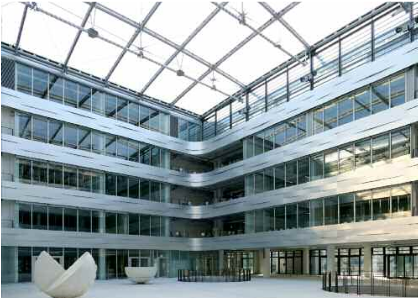
▲ Lichtdurchflutetes Atrium kurz vor der Fertigstellung
