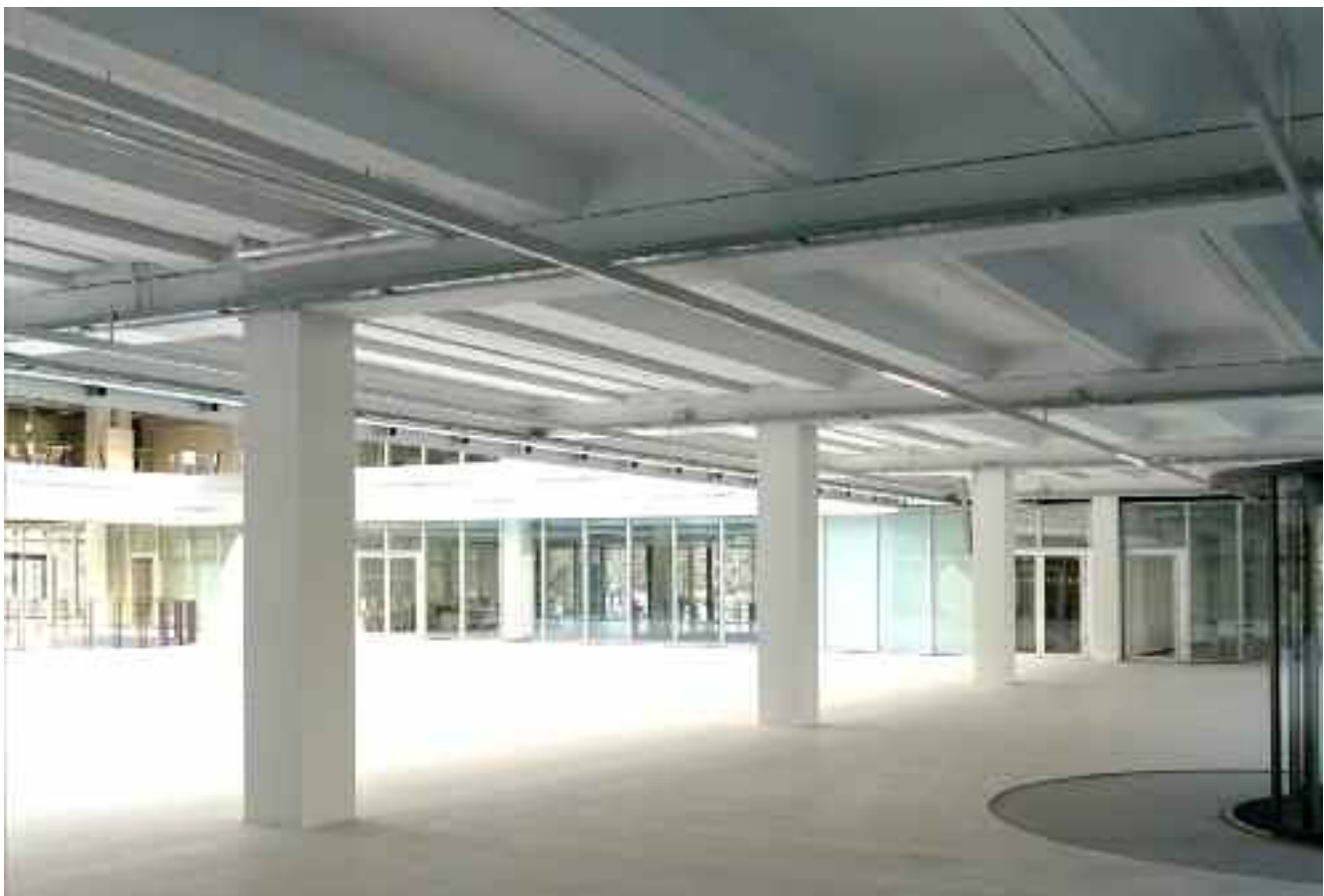
▲ Betonkonstruktion mit auskragenden Deckenträgern während der Sanierung
