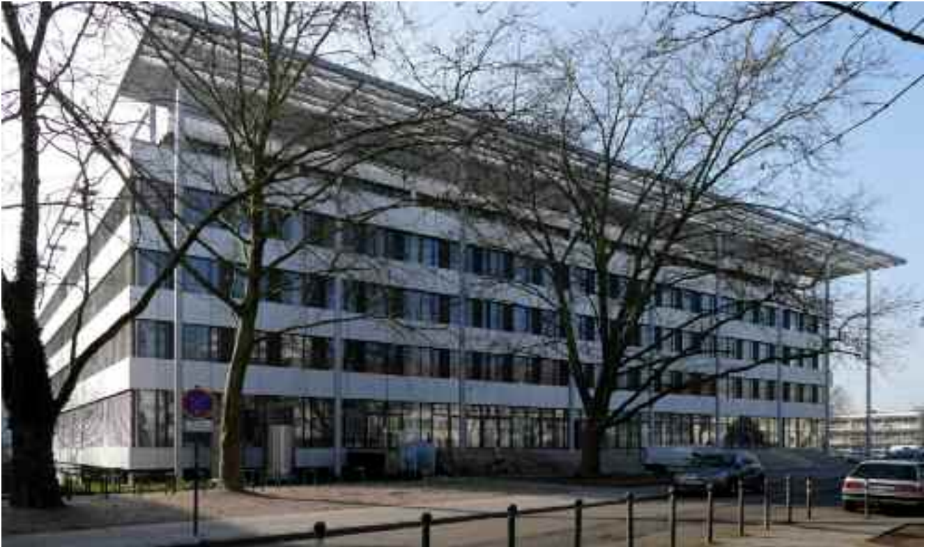
▲ Gesamtes Gebäude nach der Fertigstellung
